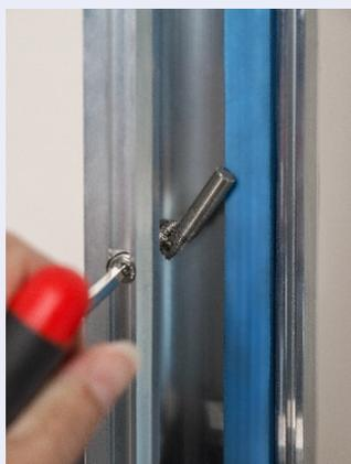
Leichtes Einsetzen und Verspannen des Dammbalkenschutzes
