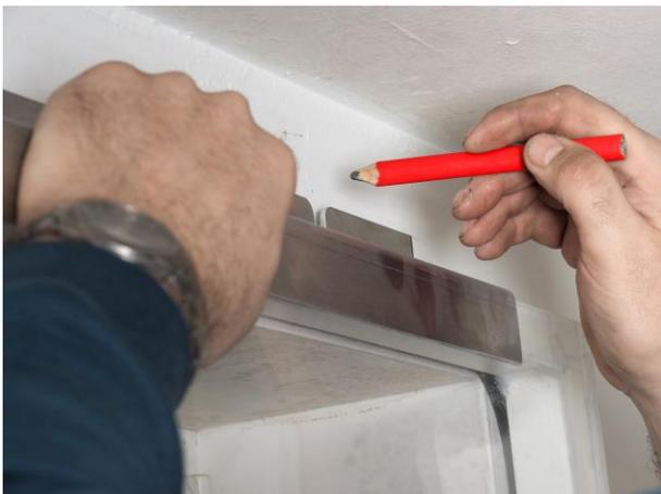
13. Den Winkel ca. 3-5mm höher setzen (z.B. Meterstabblatt links und rechts unterlegen) und die Bohrlöcher erneut anzeichnen.
