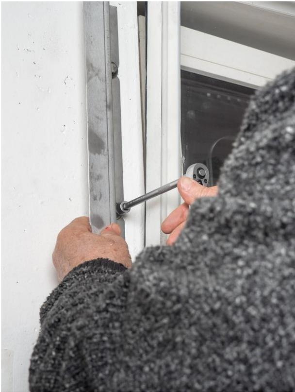
20. Winkel umdrehen und wieder mit den Schrauben befestigen.
