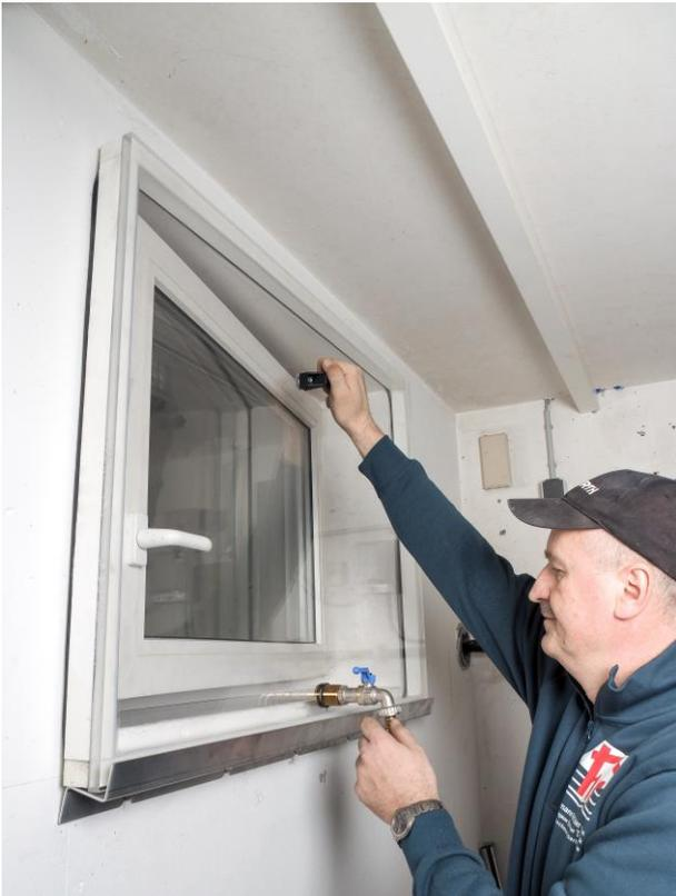
10. Scheibe von oben mittig auf dem Winkel platzieren und Schrauben etwas anziehen.
