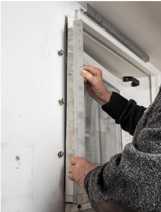
19. Den Winkel Kippen und schräg herausnehmen ggf. die Schrauben noch etwas lösen.
