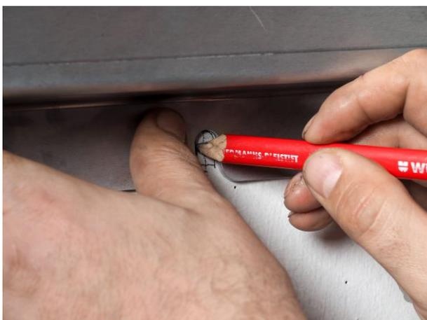
4. Anzeichnen der Bohrlöcher für die Befestigung der Winkel
