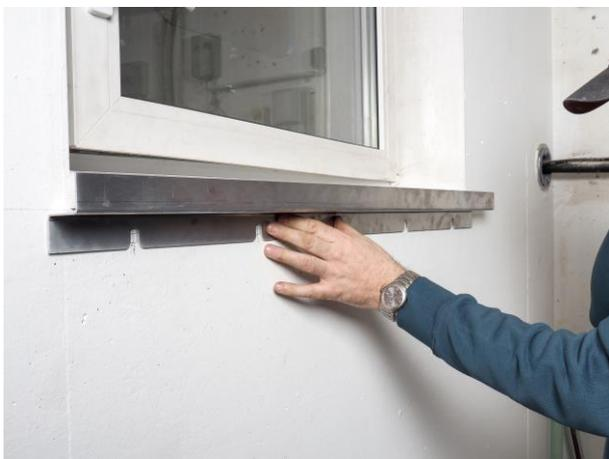
3. Den längeren unteren Winkel mittig an der Linie anlegen. Die Auflagefläche für die Scheibe liegt an der Linie an.
