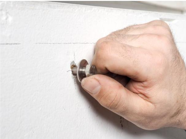
7. Dübel einsetzen und danach die Schrauben in die Dübel drehen. Schrauben nicht fest drehen, damit genug Platz bleibt, den Winkel einzusetzen.
