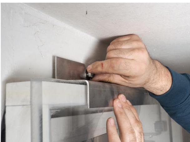
15. Die Dübel einsetzen und auch hier die Schrauben anbringen.
