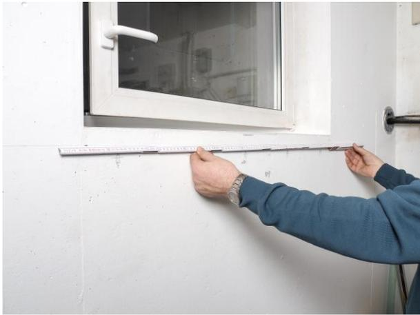
1. Scheibe und Fensteröffnung ausmessen und die Platzierung des Hochwasserschutzes festlegen - wenn möglich mittig ausrichten.
