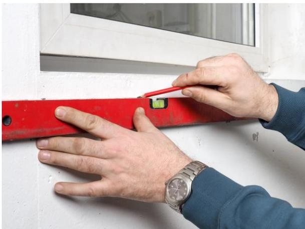
2. Scheibenmaß mit Hilfe der Wasserwaage auf die Wand übertragen.
