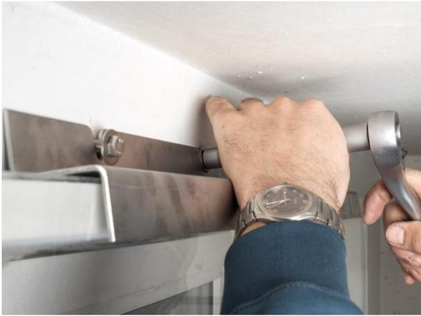
16. Mit Hilfe eines Schlüssels/einer Ratsche alle Schrauben anziehen (oberer und unterer Winkel).
