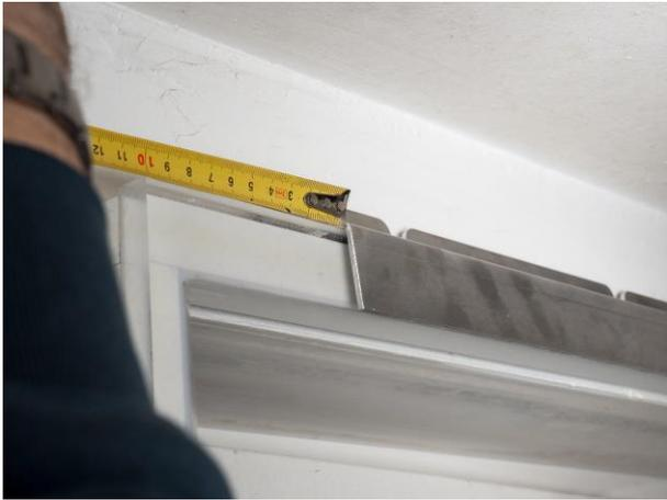
12. Den Winkel mit Hilfe von Meterstab/Maßband mittig ausrichten.
